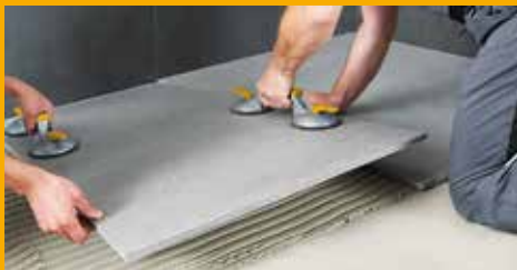
FLIESEN-, WAND- UND FUSSBODENTECHNIK
