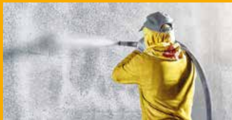
BETONSCHUTZ UND INSTANDHALTUNG
